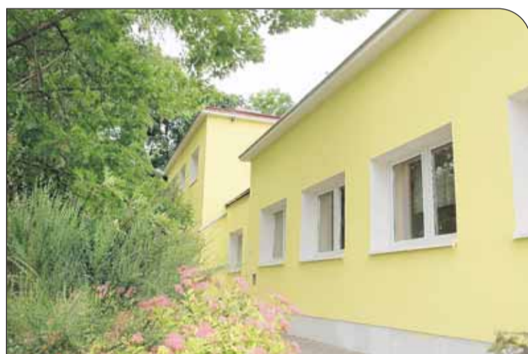
Docieplenie elewacji szkoły w Białobrzegach
