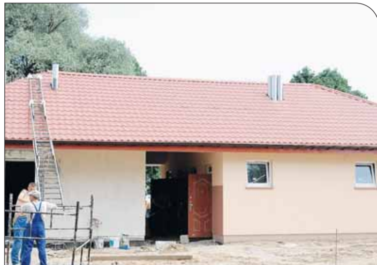
Budynek socjalny na terenie Dzikiej Plaży
